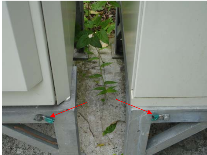
Figura 5 - Furto de cobre em uma instalação ao ar livre
