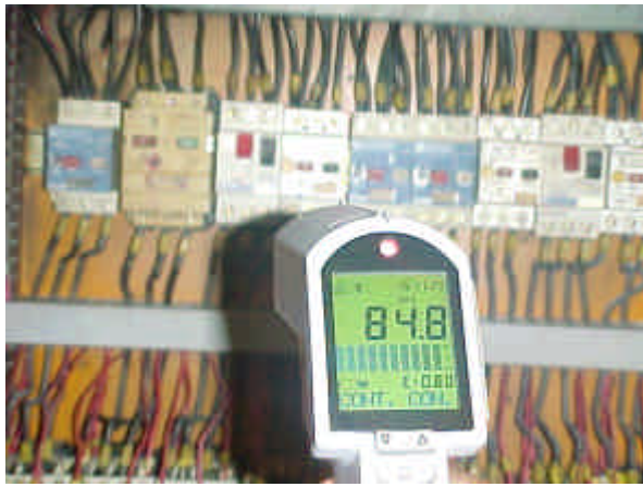
Figura 4 - Componente Defeituoso.
