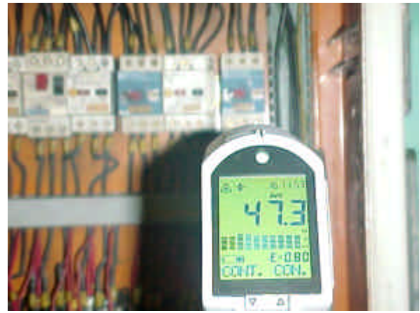
Figura 4 - Componente Defeituoso.
